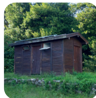
Caseta dos baños
